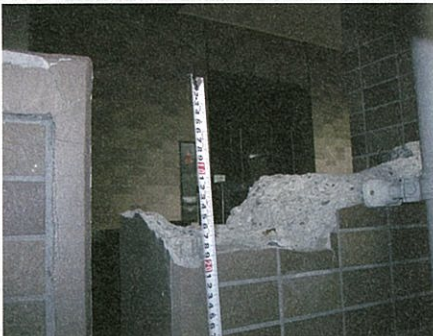
大手不動産会社が販売した都内の物件では手すりに鉄筋が入っておらず崩落した
